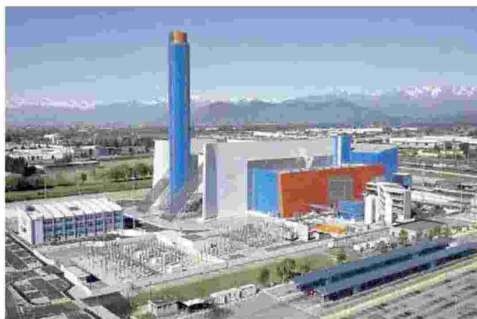
Il termovalorizzatore di Torino, simile a quello che sarà costruito a Santa Palomba
